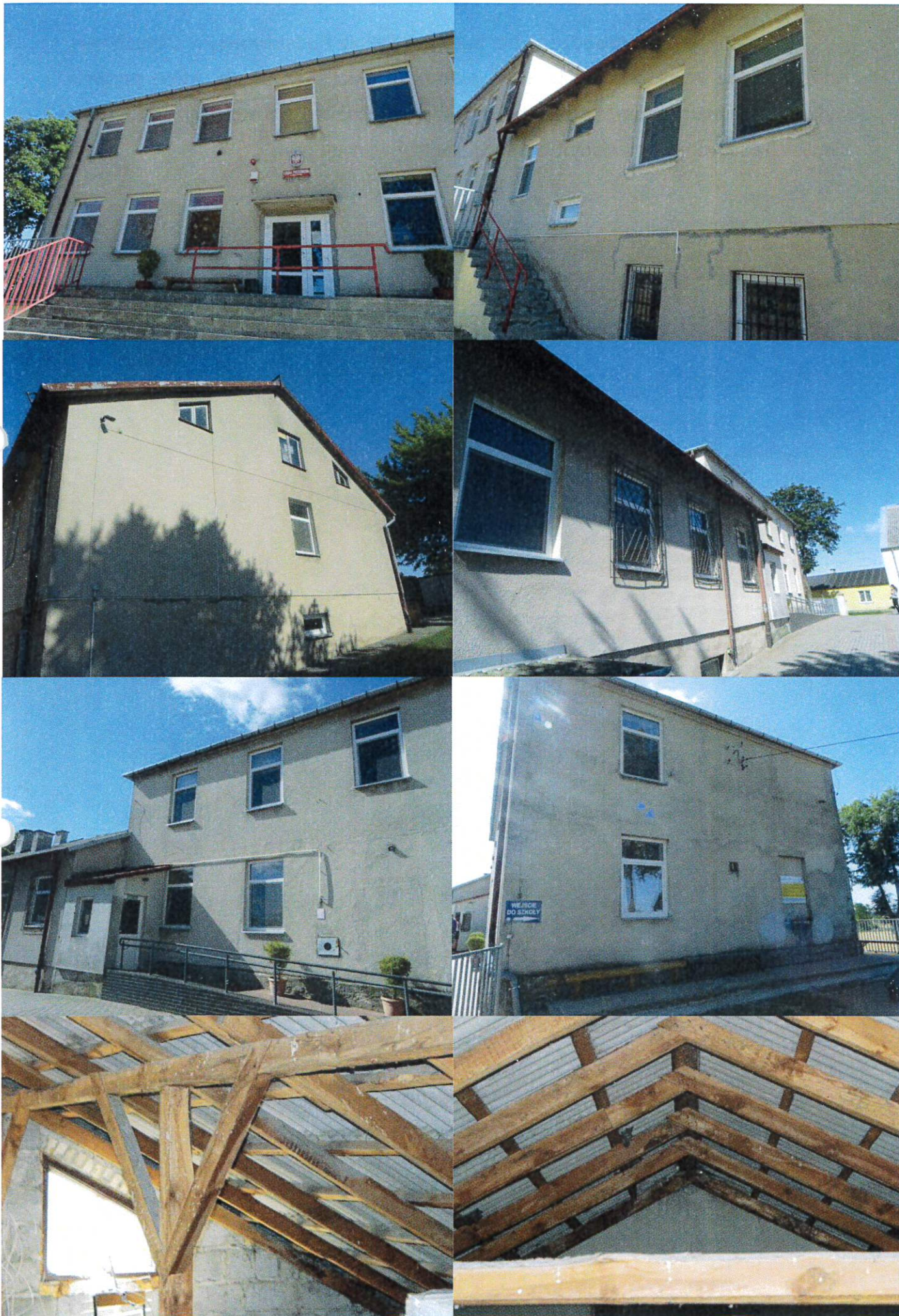
Fot. 1-8 Ściany oraz strych budynku przeznaczonych do renowacji (fot. Michał Mięsikowski).
